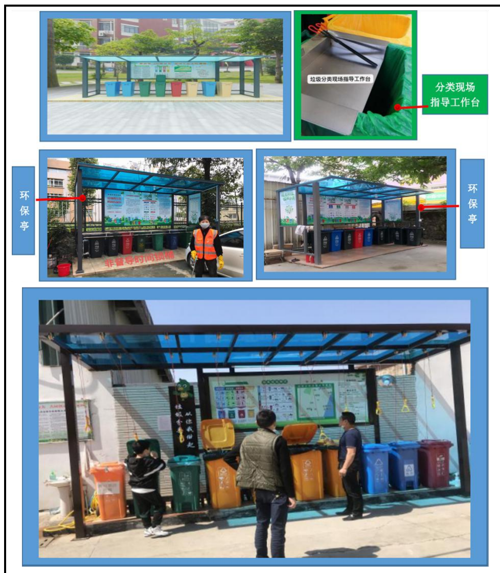
图 3.2-3 垃圾分类试点小区垃圾分类设施设置情况
