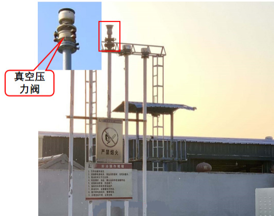
图 6-4 真空/压力阀示意图
